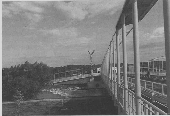
Eröffnung der neuen Traisenbrücke in St. Pölten am 5. Juli 1989.
