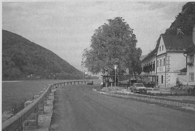
Im Zuge des Ausbaues der B 33 im Bereich Aggsbach-Dorf wurde die neue Straße auf eine Länge von rd. 400 m durch Vorschüttung in den Donaustrom verlegt. Durch diese Maßnahme konnte ein Gastgarten mit mächtigen Kastanienbäumen erhalten bleiben. Im Ortsgebiet wurde auch das ursprünglich vorhandene Geländer aus gemauerten Pfeilern und Holzquerbalken wieder hergestellt.
