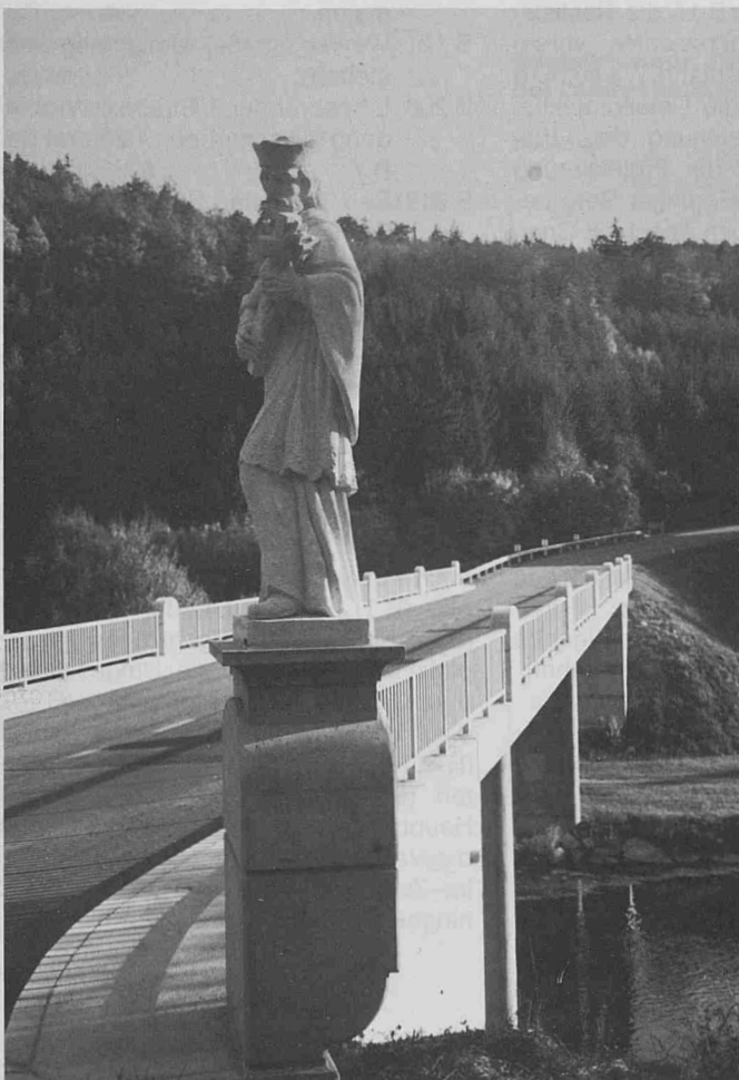
Landesstraße L 8006, Kampbrücke in Rosenberg
