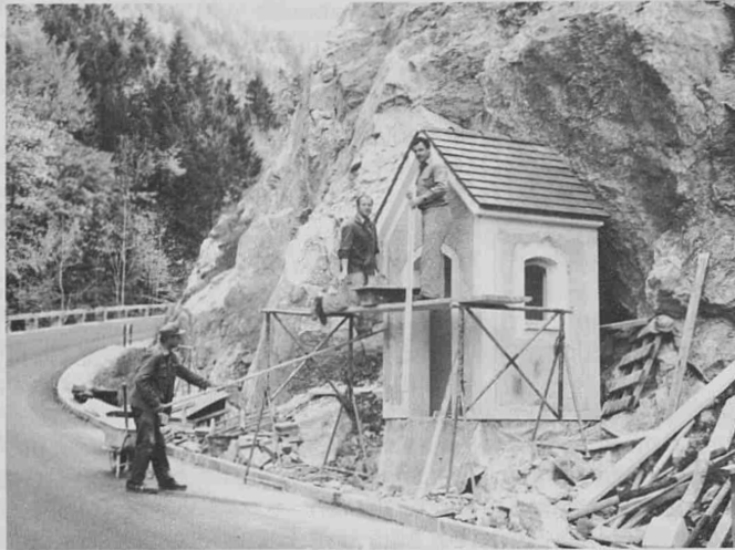
Landeshauptstraße LH 98, Abschnitt „Ybbsitz-Noth“ Die LH 98 urde im Abschnitt „Ybbsitz-Noth“ ortsbildgerecht ausgebaut. Fünf neu errichtete Kapellen, eine Gedenkstätte sowie die 1781 erbaute Schöne-Kreuz-Kapelle laden zum Verweilen ein. (Foto: NÖ Straßenverwaltung)
