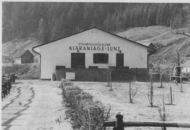
Kläranlage Lunz am See (Foto: Dipl.-Ing. Pfeiffer)
