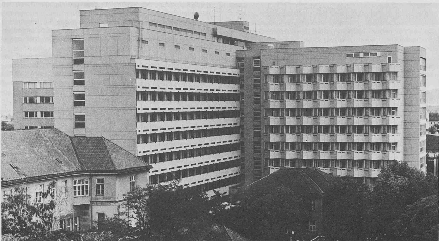
In St. Pölten wurde am 16. Oktober 1981 der erste Bauabschnitt des neuen Schwerpunktkrankenhauses eröffnet. An den Errichtungskosten beteiligte sich das Land Niederösterreich mit 60 Prozent. (Foto: Boltz)
