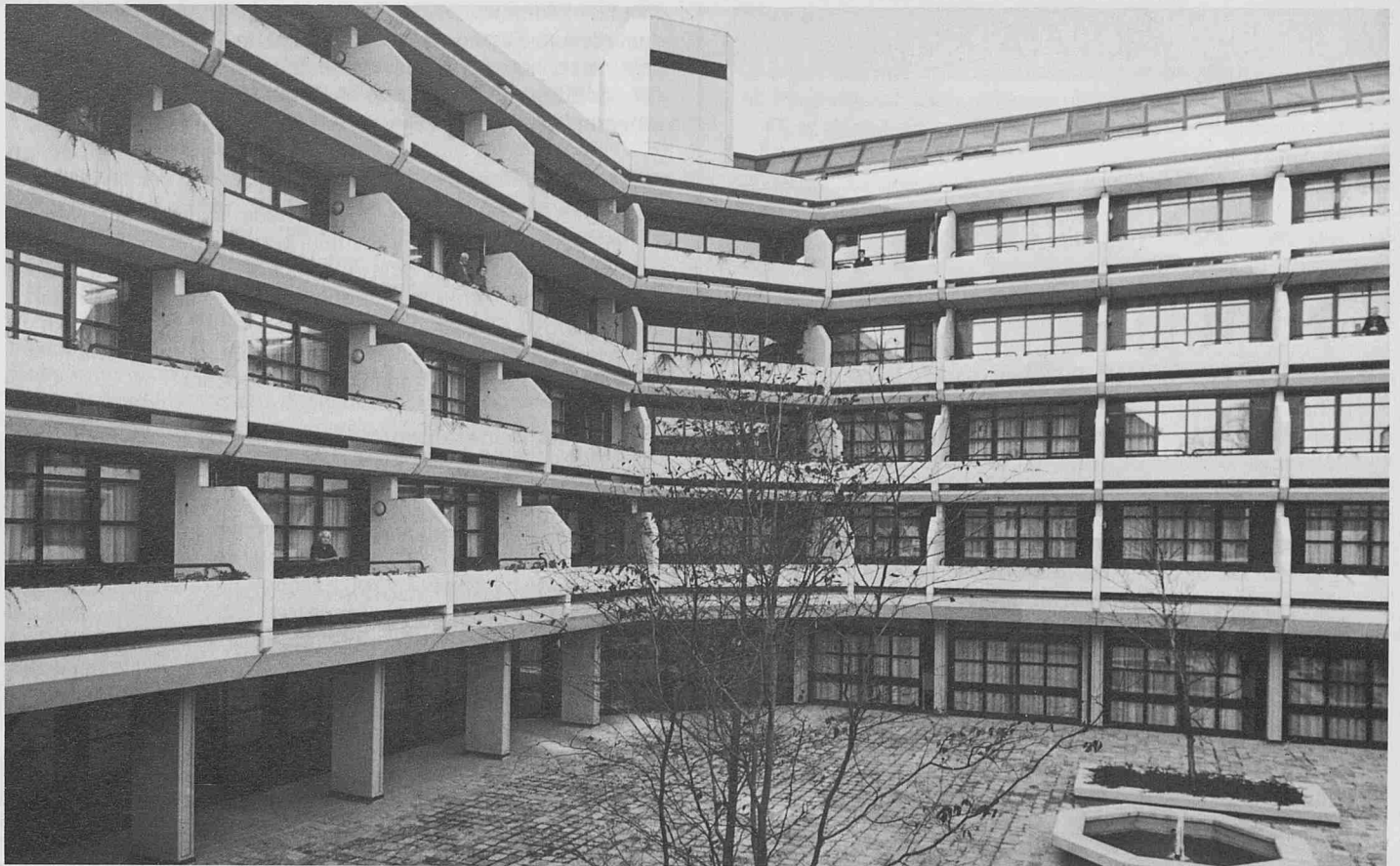
In Klosterneuburg-Kritzendorf wurde am 23. November 1981 ein neues Alten- und Pflegeheim des Ordens der Barmherzigen Brüder eröffnet. Das Land Niederösterreich hat über die Wohnbauförderung zu den Baukosten beigetragen. (Foto: Mayer)
