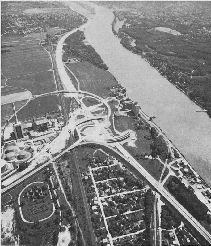
A 22, Donauufer Autobahn, Arbeiten in den Baulosen Langenzersdorf und Knoten Korneuburg
