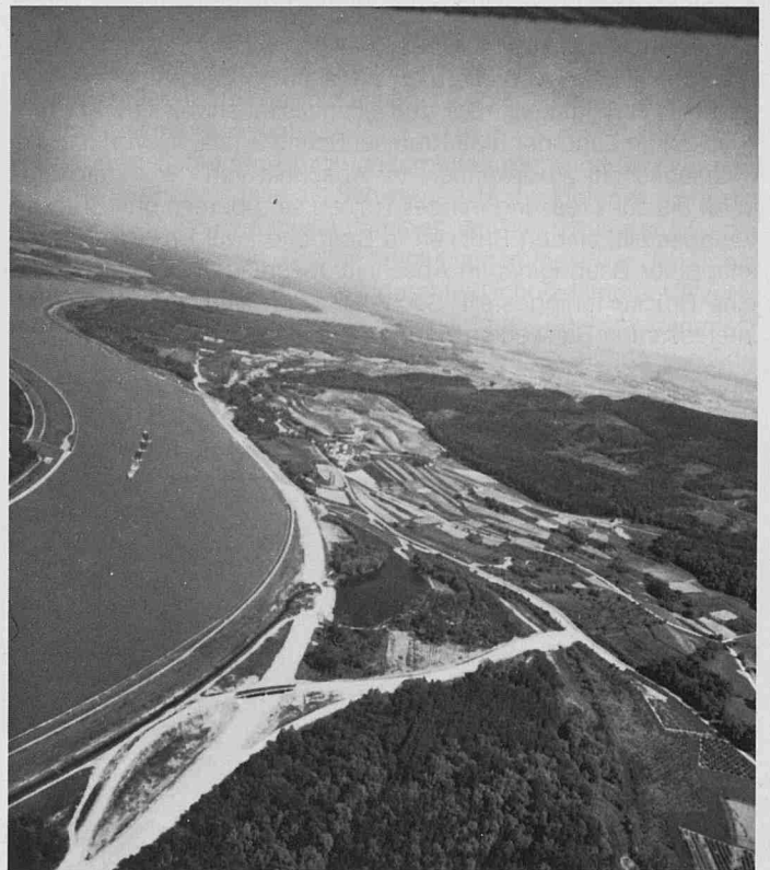
S 33, Kremser Schnellstraße, Arbeiten im Abschnitt Hollenburg—Krems-Süd
