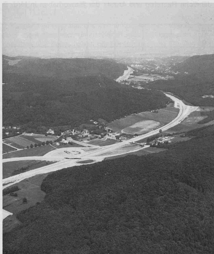
A 21, Wiener Außenring Autobahn, Erdarbeiten im Bereich der Anschlußstelle Hinterbrühl
