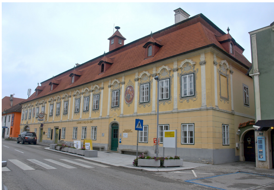
Abbildung 4: Die in Strengberg gelegene Poststation wurde 1689 errichtet. Im zweiten Viertel des 18. Jahrhunderts wurde die Poststation unter dem damaligen Poststationsbesitzer Sigmund Öttl umgebaut. Das Posthaus erhielt in dieser Zeit die spätbarocke Fassadendekoration, die es heute noch trägt.
